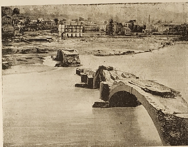
Die völlig zerstörte Brücke von Ovada in Norditalien. Auf der gegenüberliegenden Seite sind die Häuser durch die Wassermassen vollkommen zerstört.
